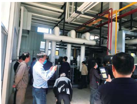
参观京东物流新建 3 万平方米大型冷库现场
